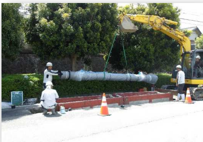
【配管布設替工事】
