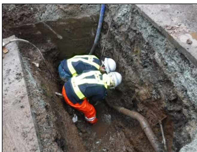
【漏水管修繕状況】
