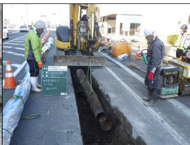
【老朽管撤去状況】
