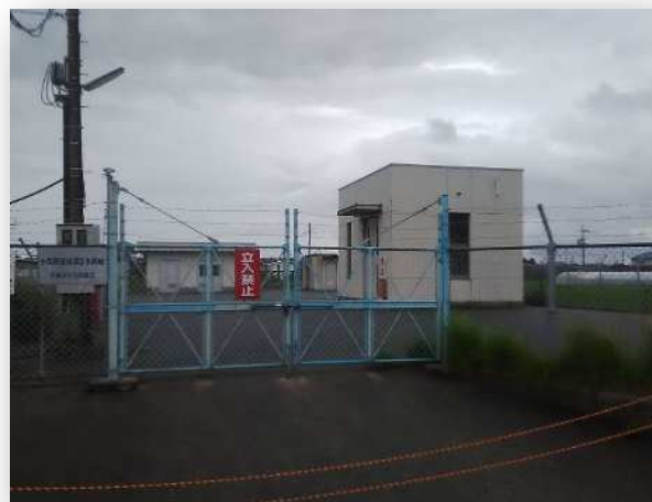
【宮前第2水源地】
