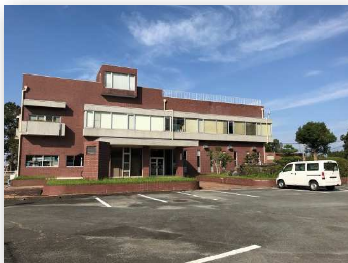
【中須水源地水道管理センター】
